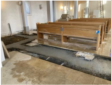
Fundament für Glaswand und WC-Kubus
